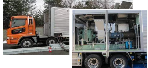
ガスタービン発電機車 (高台配備)
