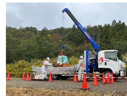
資機材搬入訓練
