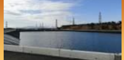
淡水貯水池設置
