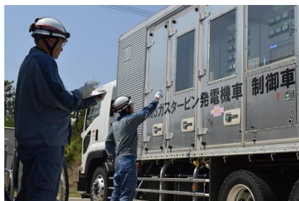
<ガスタービン発電機車起動訓練>
