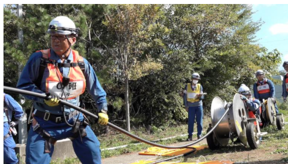
6kVケーブル送り出し
