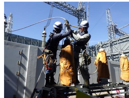
仮設ケーブル終端接続部設置
