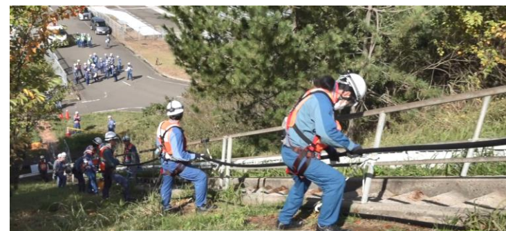
6kVケーブル法面布設
