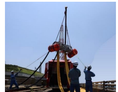
②水中ポンプの吊し上げ
