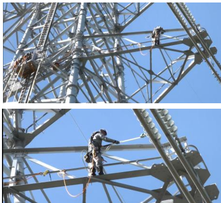
送電線の検電
