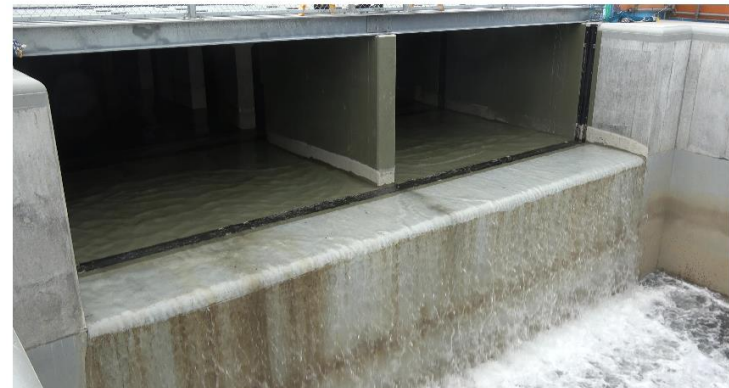
海水で希釈したALPS処理水が 上流水槽から下流水槽に越流している様子
