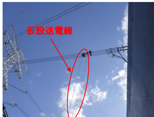
既設送電線より仮設送電線設置
