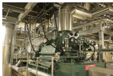
原子炉隔離時冷却系 (RCIC)
