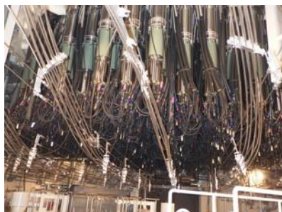
原子炉内蔵型再循環ポンプ
