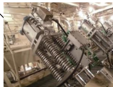
主蒸気隔離弁
