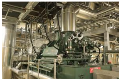
原子炉隔離時冷却系 (RCIC)
