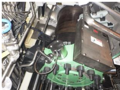
原子炉内蔵型再循環ポンプ
