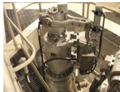
主蒸気隔離弁
