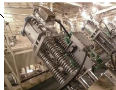
主蒸気隔離弁
