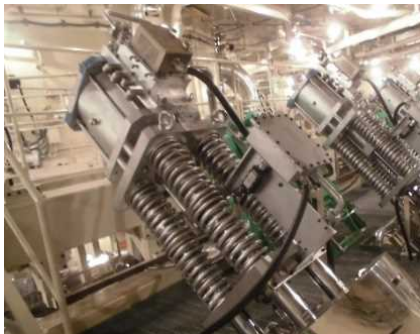
②主蒸気隔離弁（内側）
