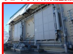
ブローアウトパネル閉止装置
