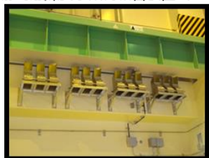
静的触媒式水素再結合装置 (PAR)
