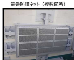
建屋の開口部に設置し、電巻により飛来した物の侵入を防止
