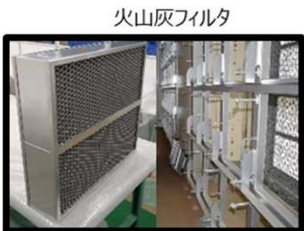
火山噴火による降灰時、非常用ディーゼル発電設備が火山灰で目詰まりしないよう、給気口にフィルタを設置
