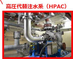
原子炉隔離時冷却系 (RCIC) のバックアップとして、原子炉へ注水
