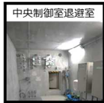
炉心損傷が発生後、格納容器の圧力逃し操作を実施した際の、運転員の被ばくを低減させるための待避場所として使用
