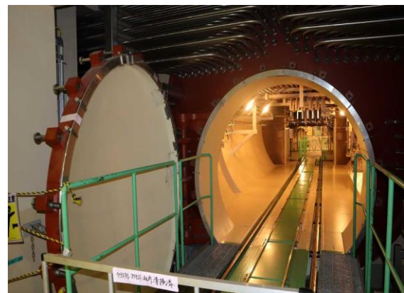
確認するハッチの例 下部格納容器（ドライウェル）ハッチ
