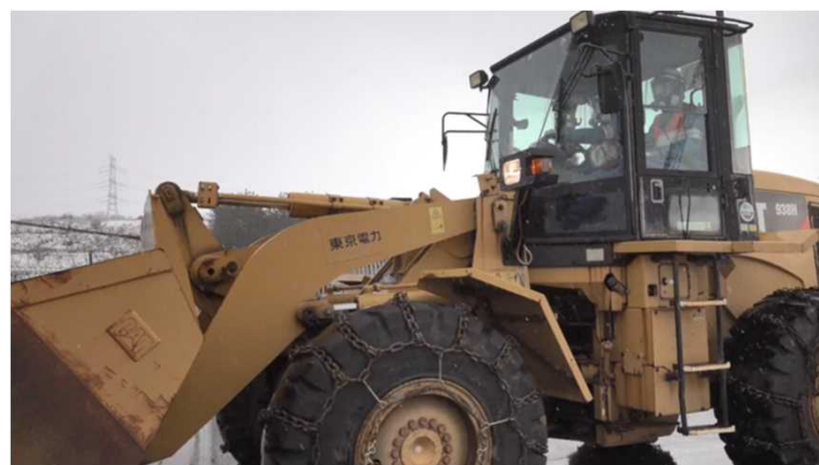
ホイールローダーを使用したがれき撤去
