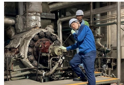
火力発電所での実機体感訓練
