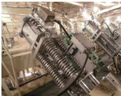
④主蒸気逃がし安全弁
