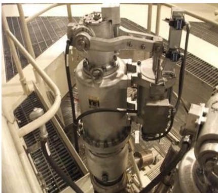
④主蒸気逃がし安全弁
