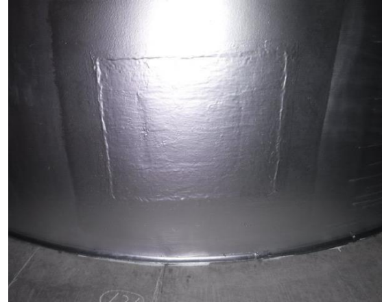
配管外側（補修後）
