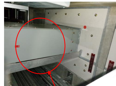
e. 6・7号機コントロール建屋
