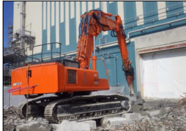
基礎解体状況
