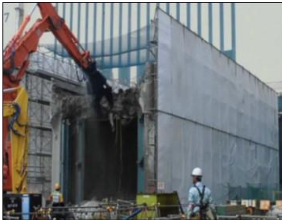
上物解体状況
