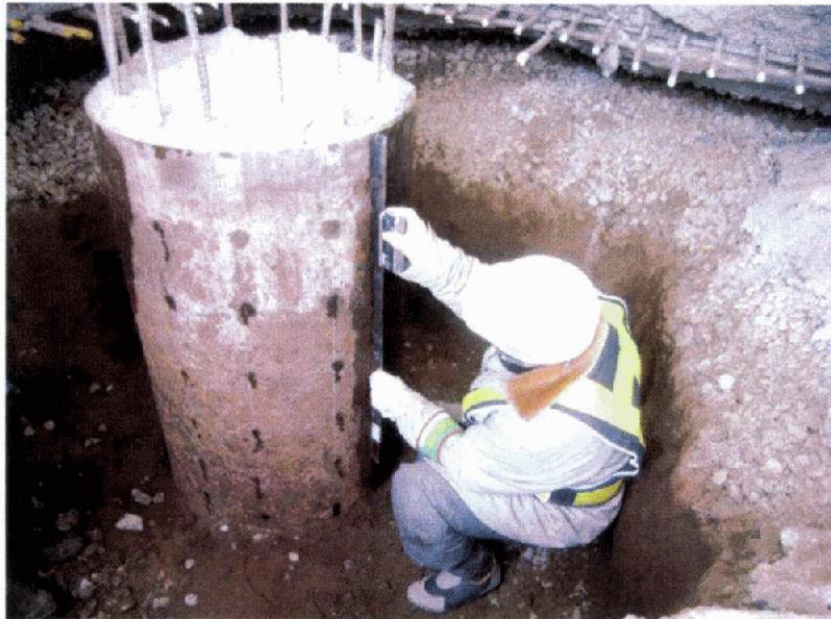
杭確認時の様子
