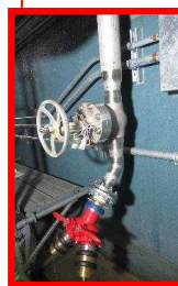
使用済燃料プールに注水するための外部接続口
