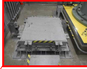
取水槽閉止板
