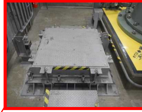
取水槽閉止板
