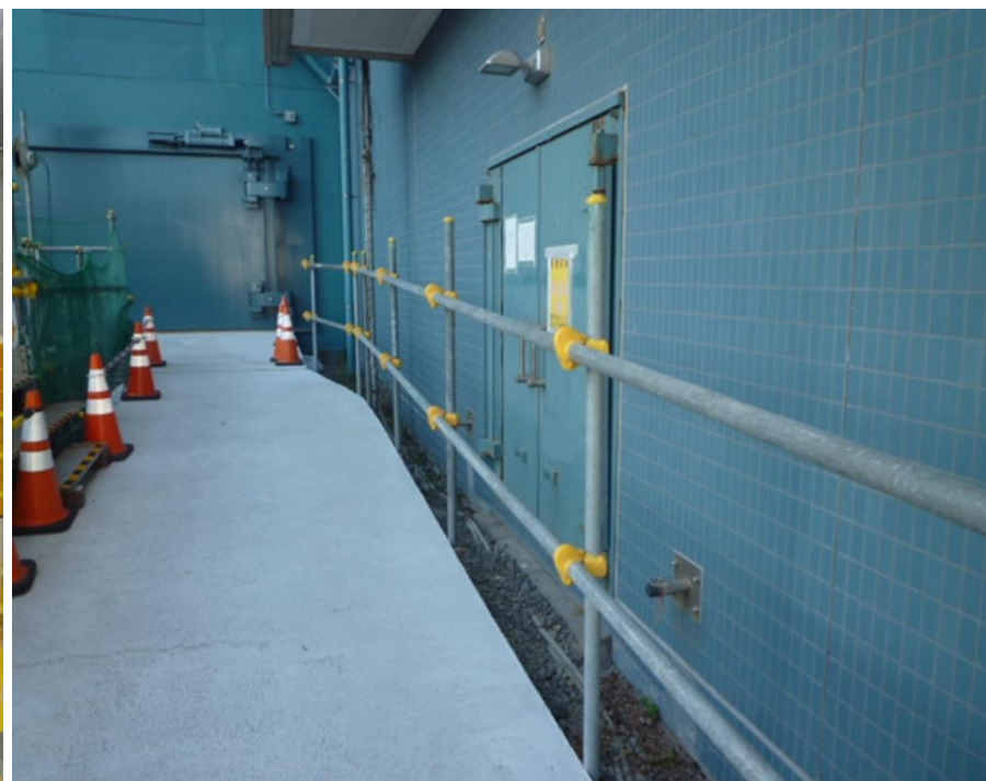
6/7号機 サービス建屋
