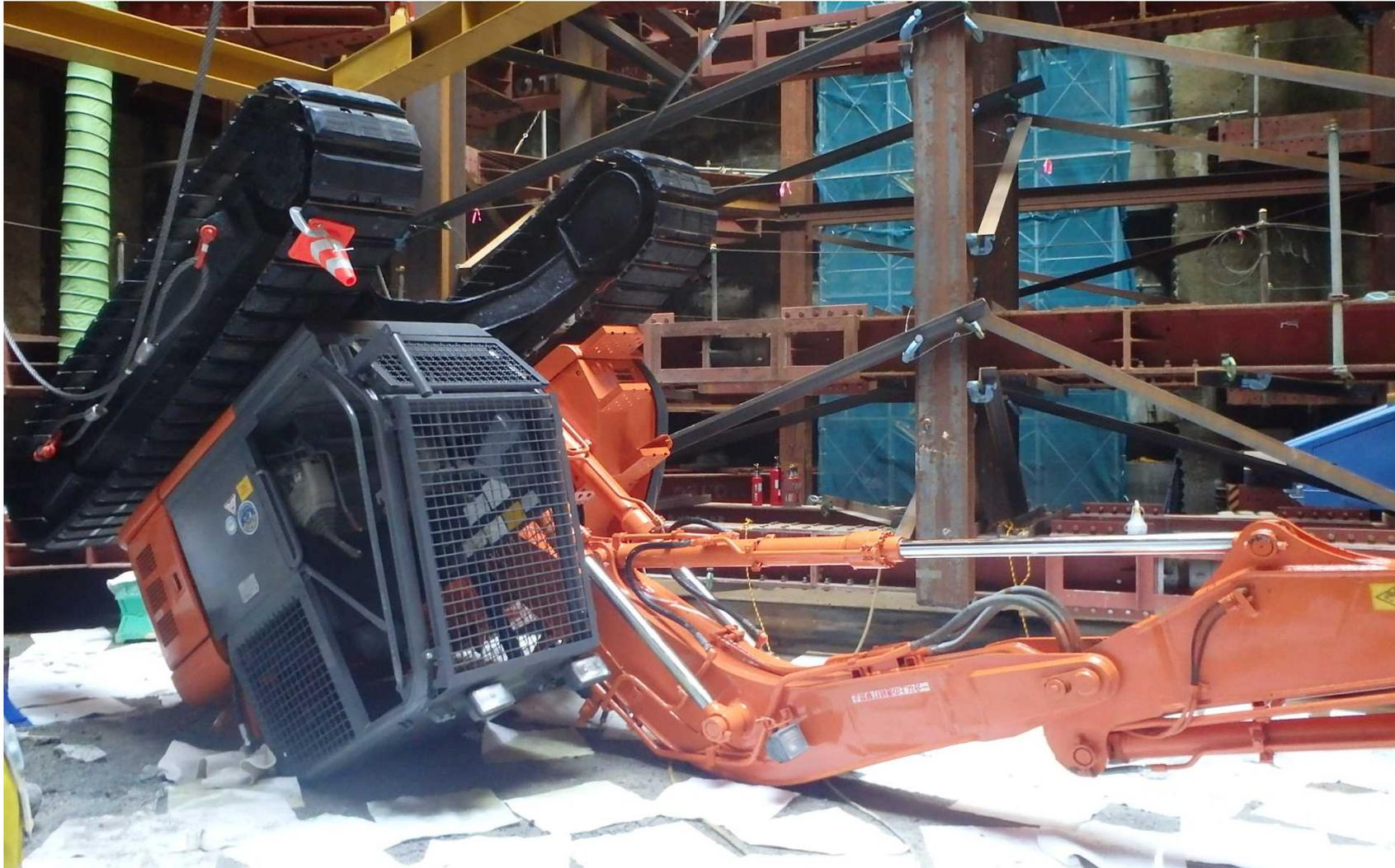
安定させるため重機をコンクリート面に下ろした状態
