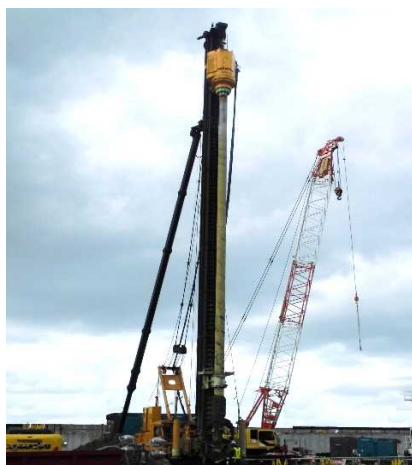
例1) 機械攪拌工法
