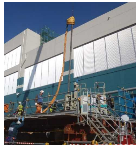
例2) 高圧噴射攪拌工法
