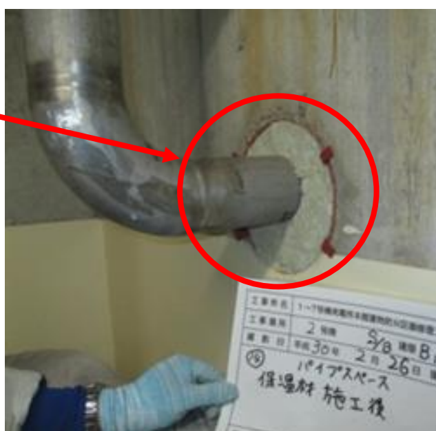
<防火処置実施後>
