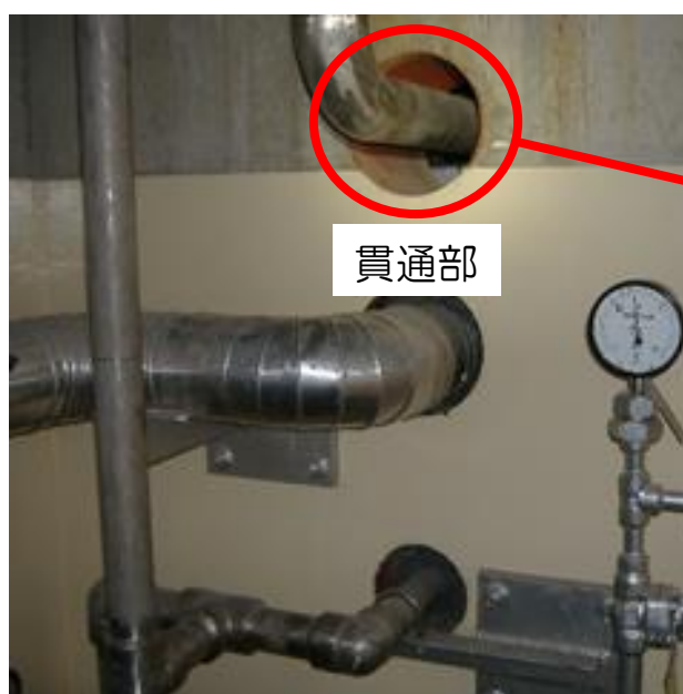
<防火処置実施前>
