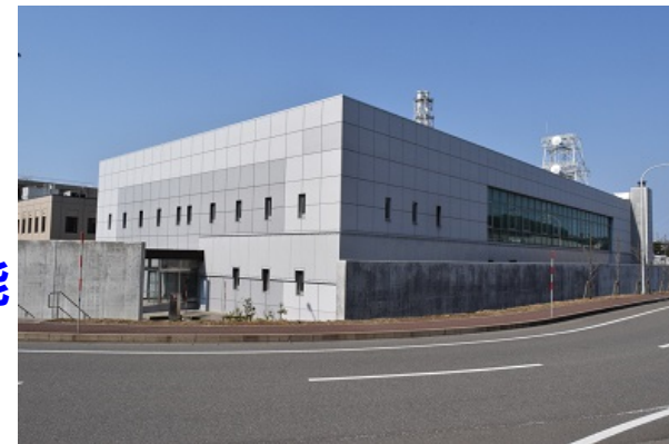
免震重要棟(外観)
