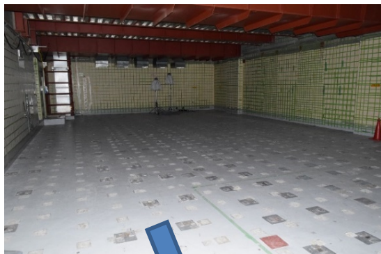
5号機原子炉建屋内 (設置工事中)
