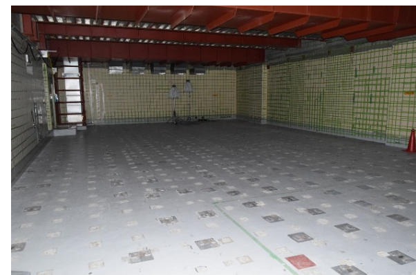
5号機原子炉建屋内 (設置工事中)
