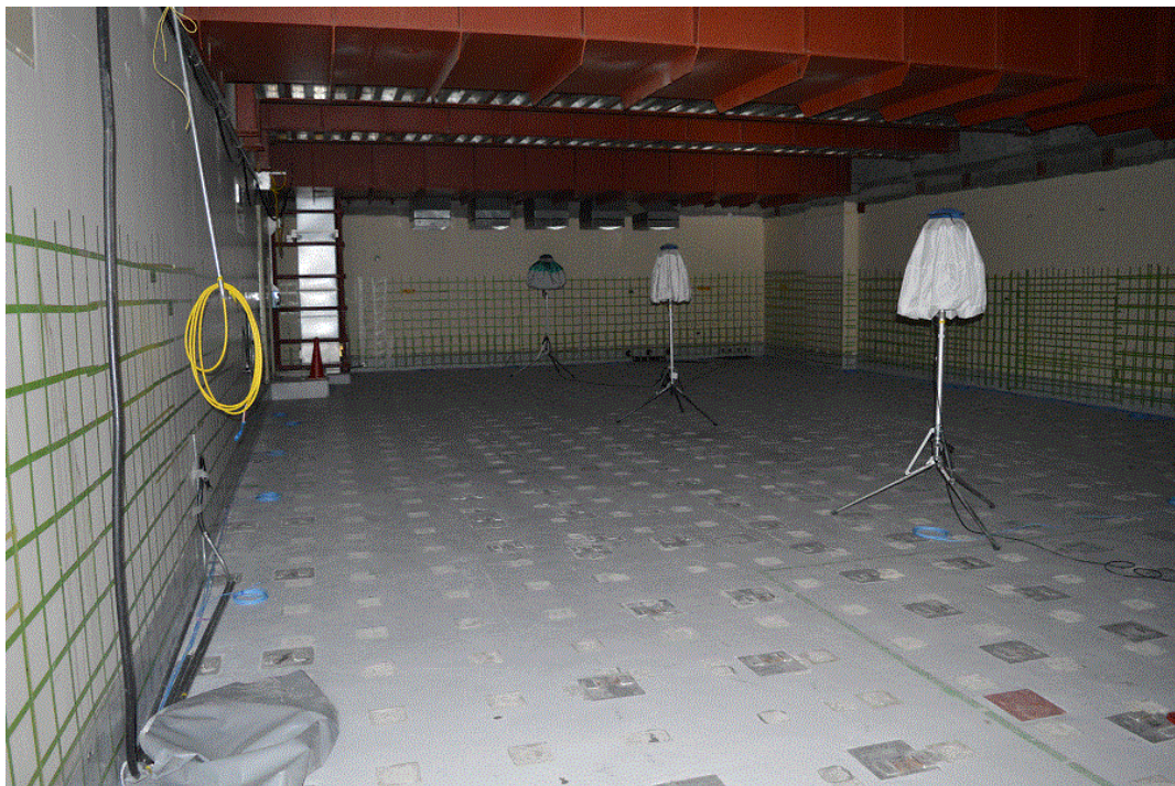
緊急時対策所の工事状況
