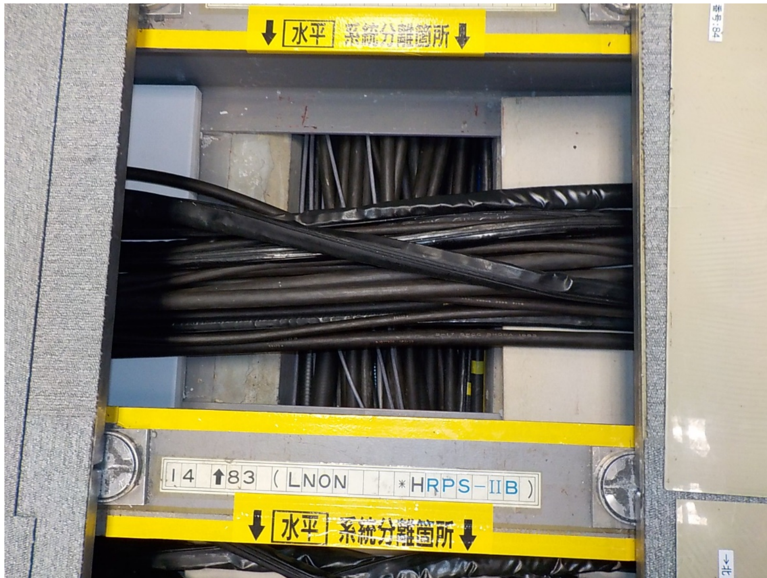
本日作業前の状況(2017年10月26日撮影)
