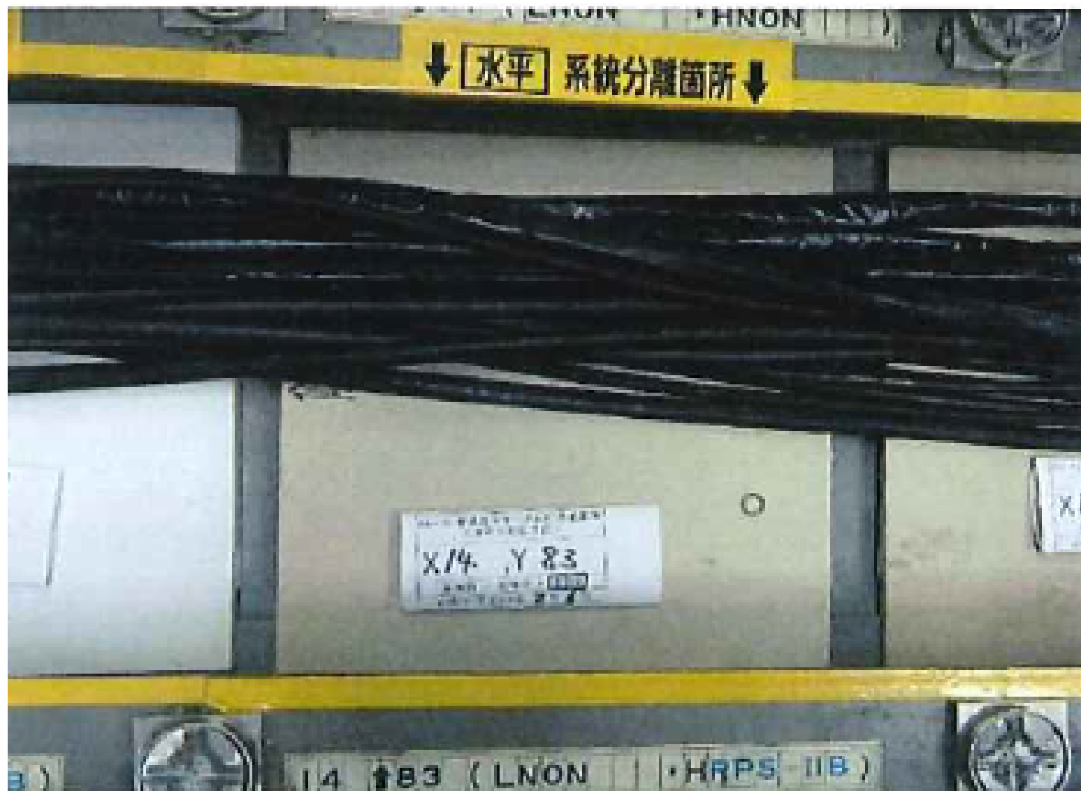
総点検後の状況(2017年2月6日撮影)
