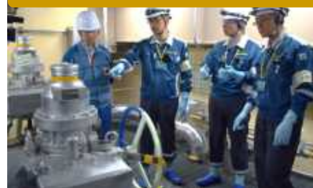
夜光塗料を塗布した弁ハンドル
