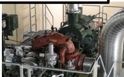
原子炉隔離時冷却系
