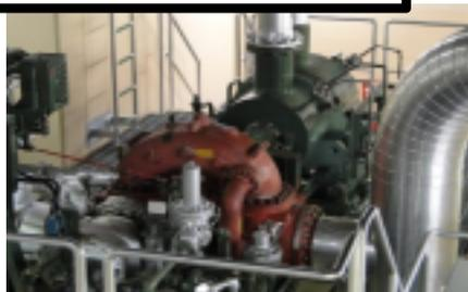
原子炉隔離時冷却系
