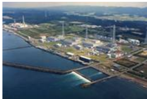
柏崎刈羽原子力発電所
