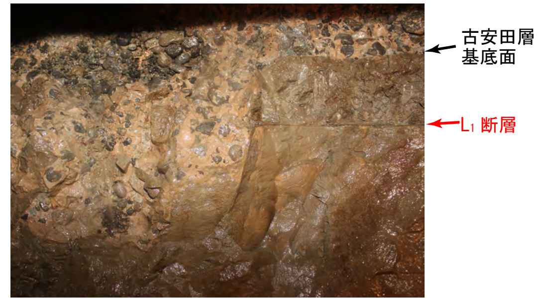
接写 C L 1 断層と古安田層基底面
