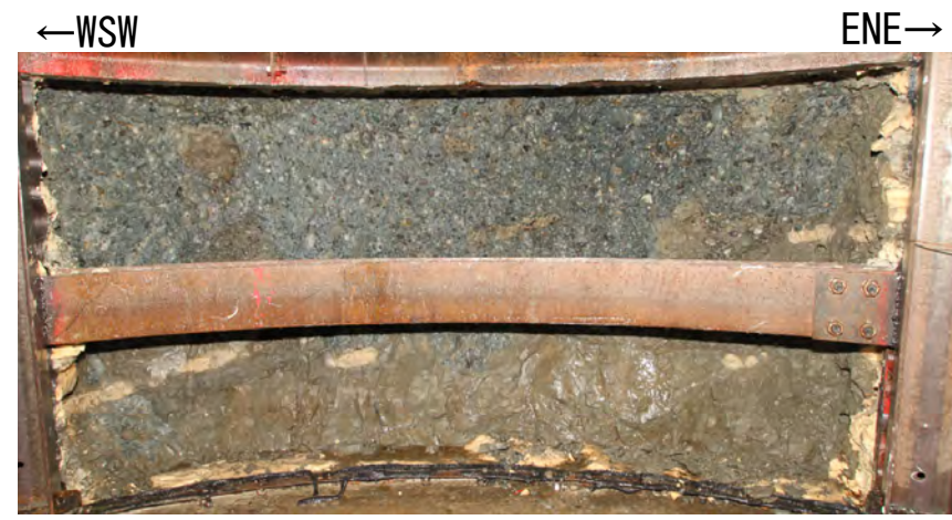
北西窓部 (全景)
