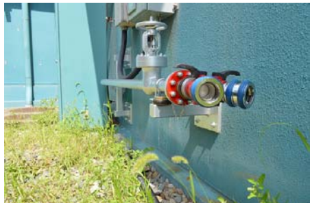
新たに設置した接続口の写真
