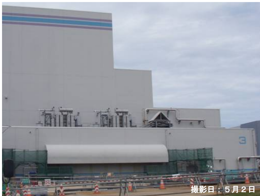
3号機 原子炉建屋東面（全景）
