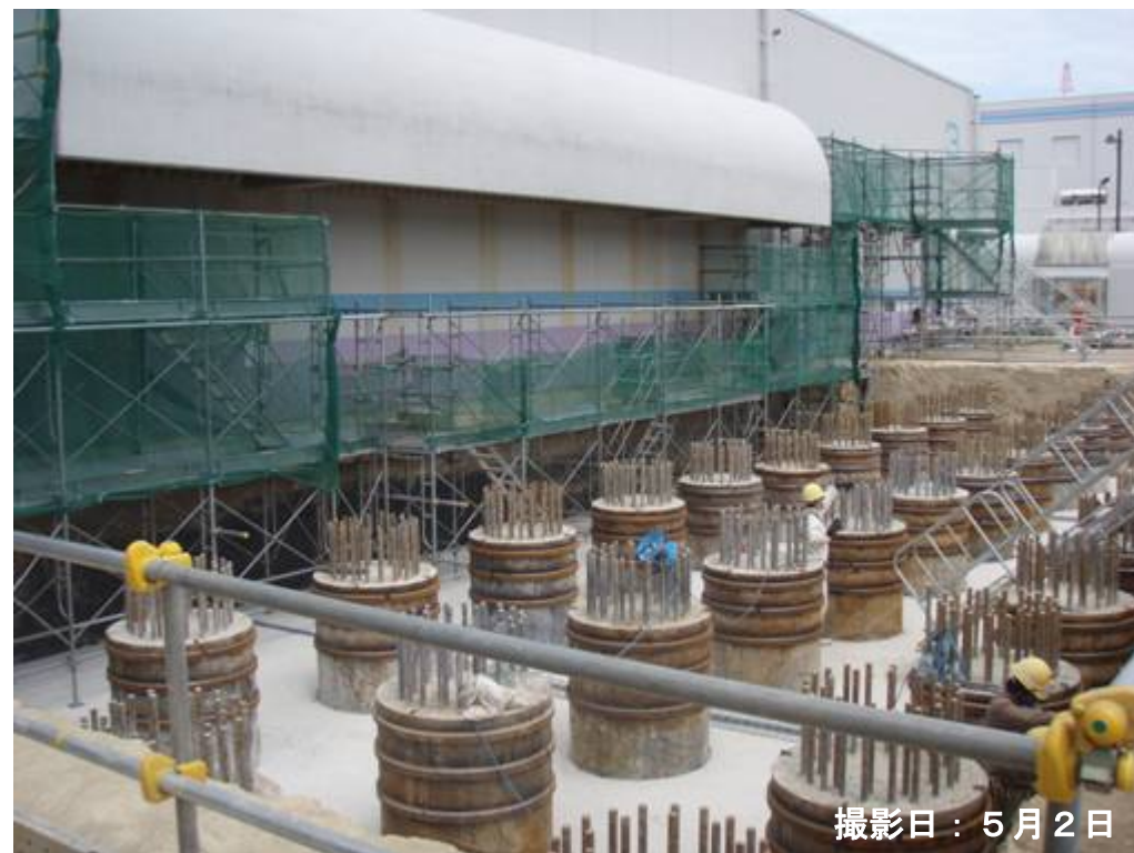
防潮壁基礎工事
