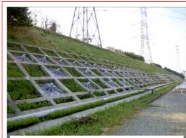
③ 超高压開閉所東側法面
