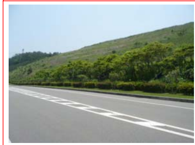
⑤ 中央展望台北側法面
