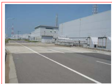
① 1号機熱交換器建屋西側道路
