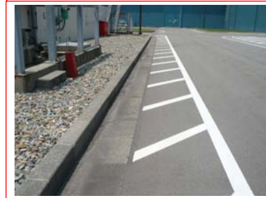
⑥ 軽油タンク周辺道路（写真は7号機）
