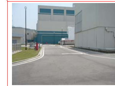
⑦ 5号機熱交換器建屋北側道路
