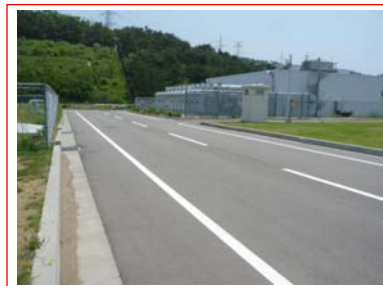
② 開閉所南側道路
