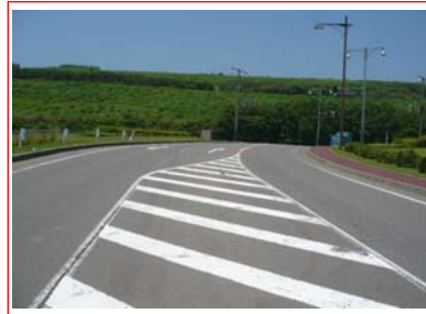
④ 防護本部進入路・法面
