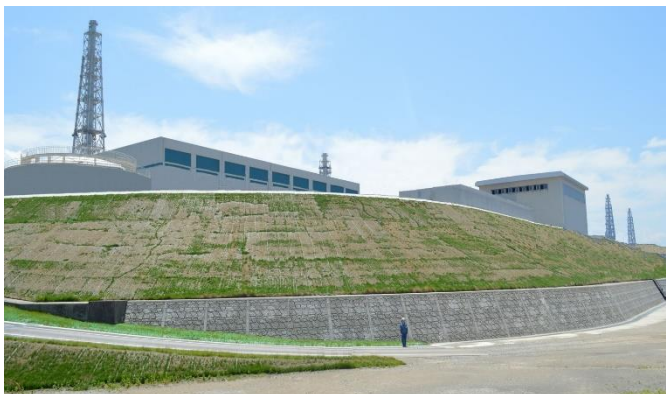
【防潮堤（5～7号機側）】
