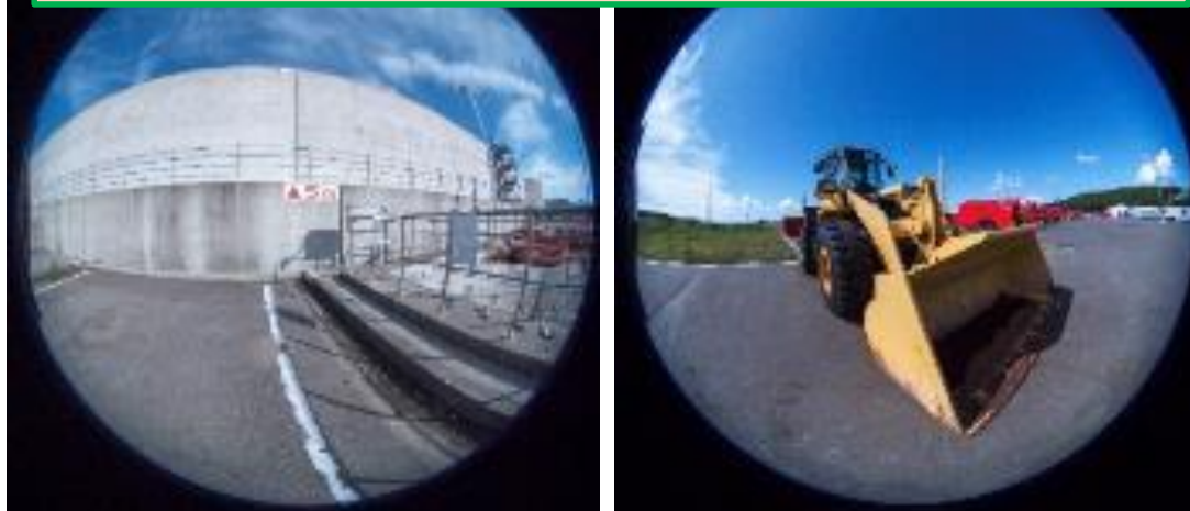
防潮堤やガレキ撤去車などの安全対策設備をご紹介するVR
