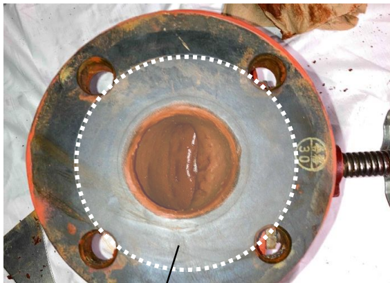
弁側のフランジ部のゴムライニング面
