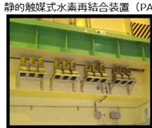
静的触媒式水素再結合装置 (PAR)
