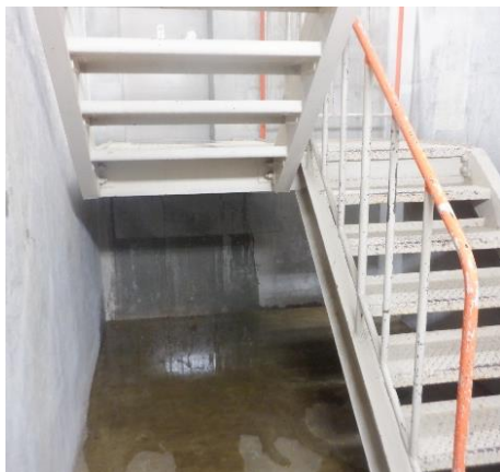
北西階段室の状況
