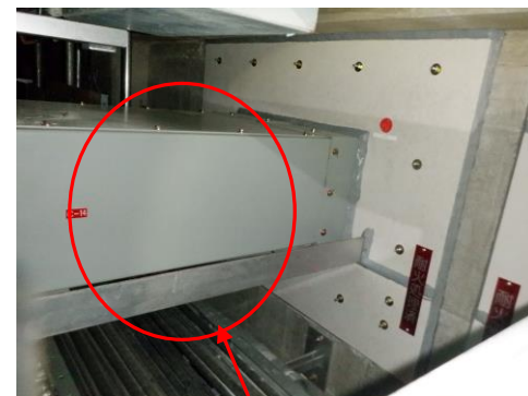
e. 6・7号機コントロール建屋
