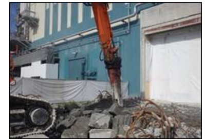
基礎解体状況
