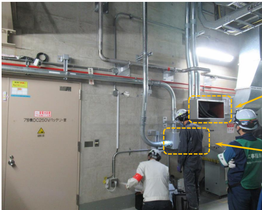
貫通部総点検の様子
