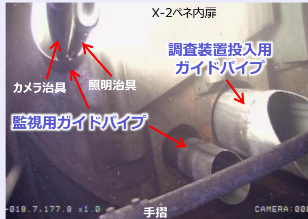
<ガイドパイプ設置状況>
