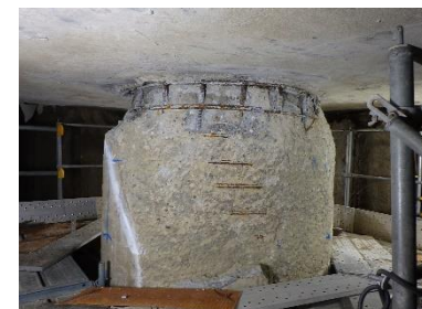
No.8 杭 コンクリートはつり後
