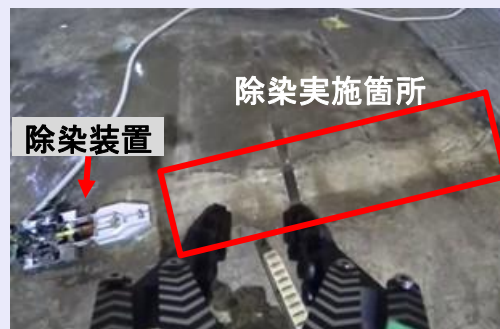
<床面の高圧水除染状況>
