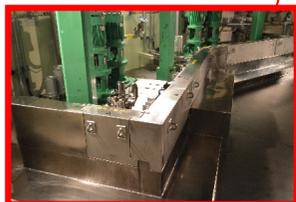
耐熱性の高い堰を設置し、溶融燃料により、鋼製の原子炉格納容器境界線の損傷を防ぐ
