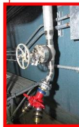
重大事故発生時に外部から使用済燃料プールに注水ができるよう、消防車を接続する
