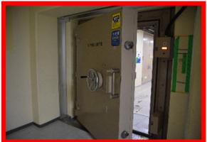
重要設備が設置されている部屋に、設備の破損で漏えいした水等の流入を防ぐ
