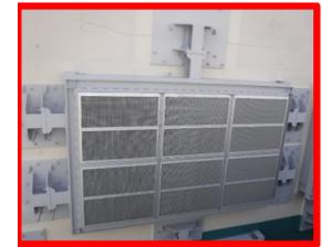
建屋の開口部に設置し、電巻により飛来した物の侵入を防止する
