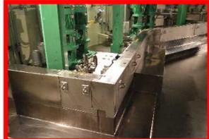
耐熱性の高い堰を設置し、溶融燃料により、鋼製の原子炉格納容器境界板の損傷を防ぐ
