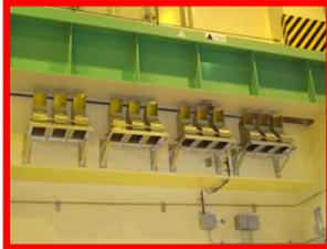
触媒の働きで、原子炉建屋に滞留した水素を酸素と再結合させ、水蒸気にする
