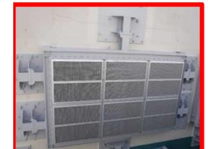
建屋の開口部に設置し、竜巻により飛来した物の侵入を防止する
