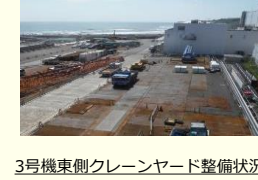
3号機東側クレーンヤード整備状況
