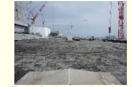
3号機タービン建屋上屋ガレキ撤去状況
