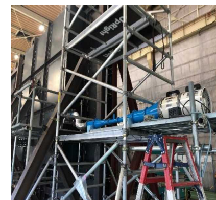
オペロBOP閉止装置気密試験状況
