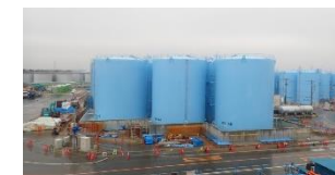
(溶接型タンク設置状況)
