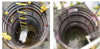
陸側遮水壁 内側 陸側遮水壁 外側
