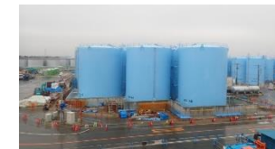
(溶接型タンク設置状況)
