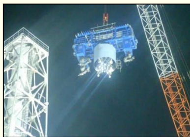
3ブロック目吊り下し状況
