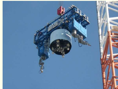
頂上ブロック吊り下ろし状況
