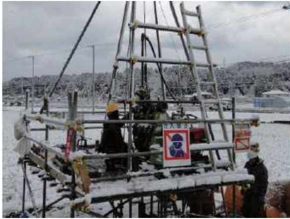
ボーリング調査
