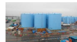
(溶接型タンク設置状況)
