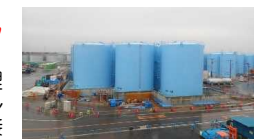
(溶接型タンク設置状況)
